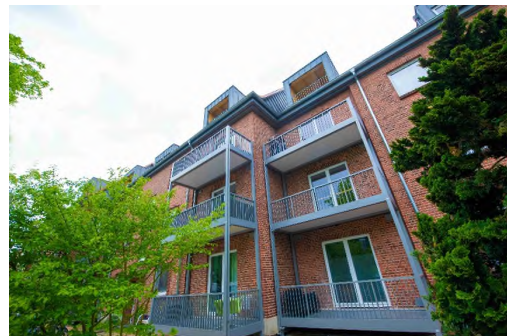
Lüner Weg 35-39 in der Modernisierung 2023
