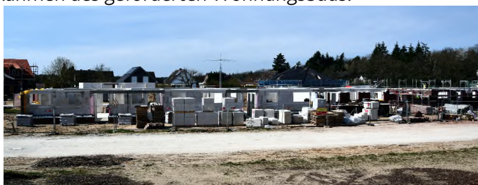
Baustelle Priolweg Barendorf im April 2020
