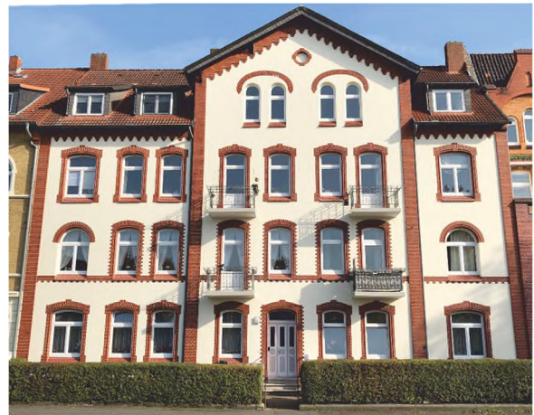
Uelzener Straße 6 nach der Fassadensanierung
